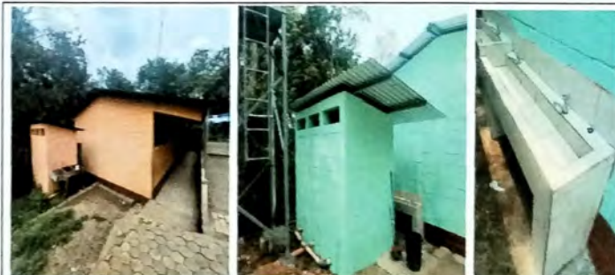
Foto 16: MODULO D vista de servicios sanitarios, cambio de estructura de metal en malas condiciones por metal, y cambio de lamina troquelada cal 26. Elaboracion de lavamanos de concreto con azulejo y griferia nueva.
