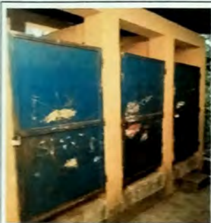
Foto 13: MODULO D cambio de puertas de metal y sustitucion de lamina de zinc por lamina troquelada cal 26.
