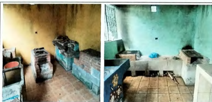
Foto 8: MODULO B remozamiento de poyeton con rejilla
