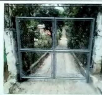
Foto 18: VISTA de porton sustitucion de puerta de metal que esta al ingreso sobre la calle principal.
