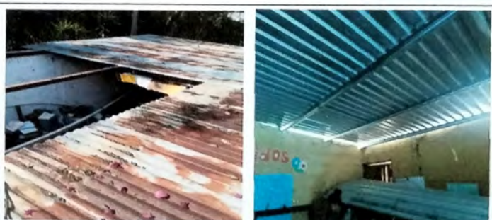
Foto 10: MODULO C Vista interna de aula cambio de lamina de zinc por lamina troquelada cal 26.
