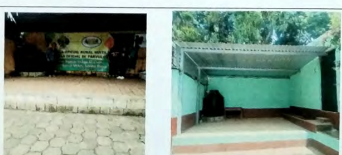
Foto 12: Vista Frontal de escenario cambio de lamina de zinc por lamina troquelada cal 26.
