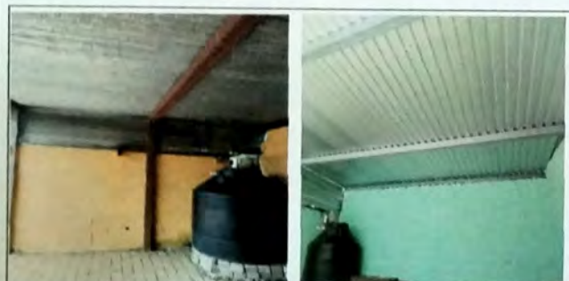
Foto 11: VISTA DE ESCENARIO cambio de lamina de zinc por lamina troquelada cal 26.
