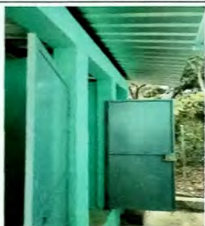
Foto 13: MODULO D cambio de puertas de metal y sustitucion de lamina de zinc por lamina troquelada cal 26.
