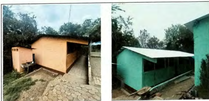
Foto 2: Vista MODULO A cambio de cubierta de lamina de zinc por lamina troquelada cal 26.
