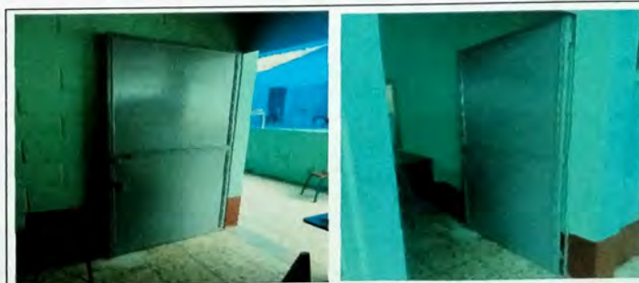
Foto 6: Vista interna MODULO A mantenimiento a puertas de metal de aulas.
