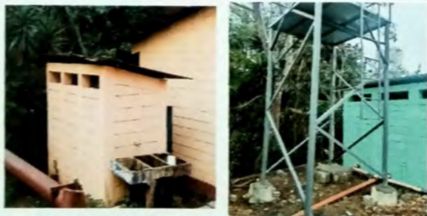
Foto 17: VISTA DE torre de metal para sosten de deposito para almacenamiento de agua potable.
