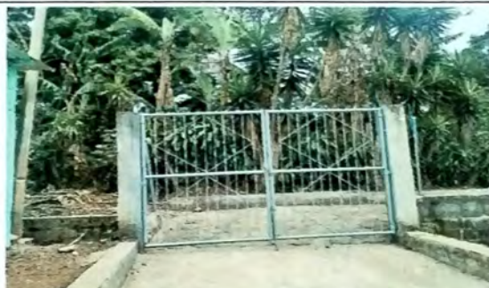
Foto 14: Sutipcion de porton de metal por porton de metal nuevo.
