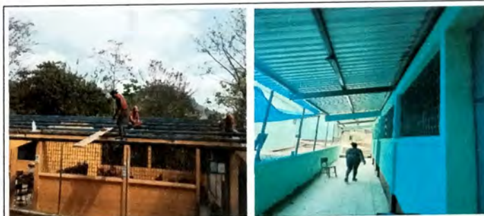
Foto 4: Vista corredor MODULO A cambio de cubierta de lamina de zinc por lamina troquelada cal 26.
