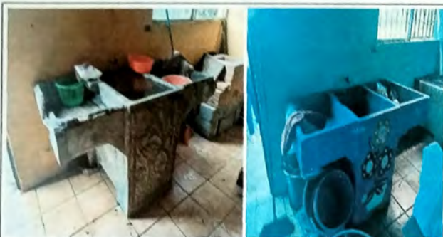
Foto 7: MODULO B area de cocina, sustitucion de pila de concreto.
