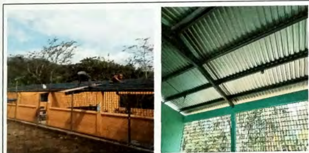
Foto 3: Vista interna MODULO A cambio de cubierta de lamina de zinc por lamina troquelada cal 26.
