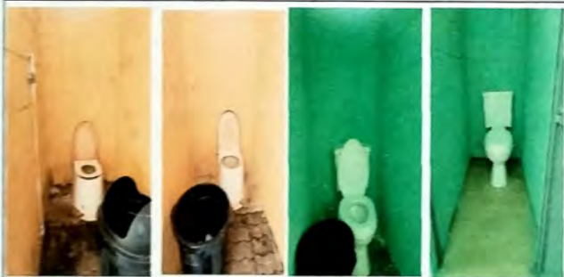
Foto 15: MODULO D vista de sustitucion de inodoros.
